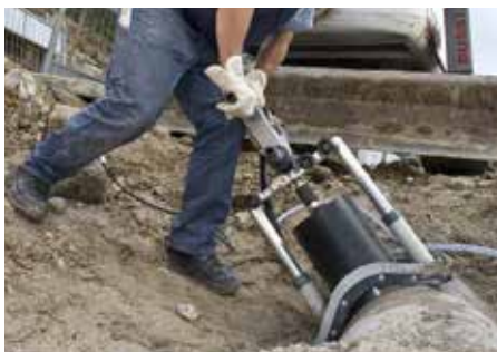
Anbohren von Betonrohr – nass, stativgeführt
