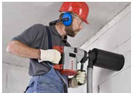
Trockenbohren in Mauerwerk mit Staubabsaugung, handgeführt
