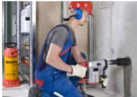
Dosensenken in Beton – nass, handgeführt
