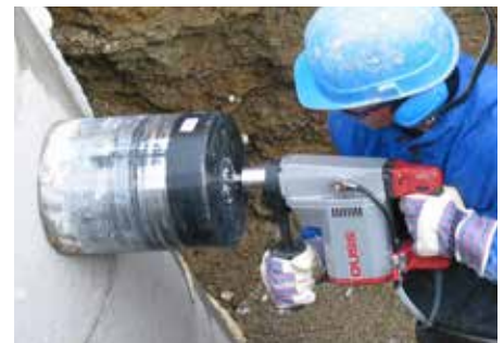
Anbohren von Betonschacht – nass, handgeführt
