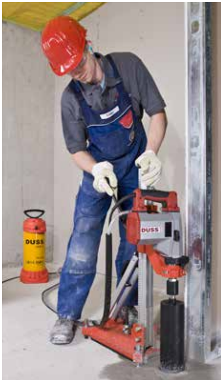
Nassbohren in Beton, ständergeführt
