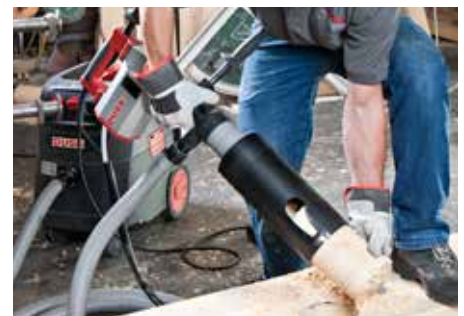
Bohren in Holz mit Staubabsaugung – handgeführt
