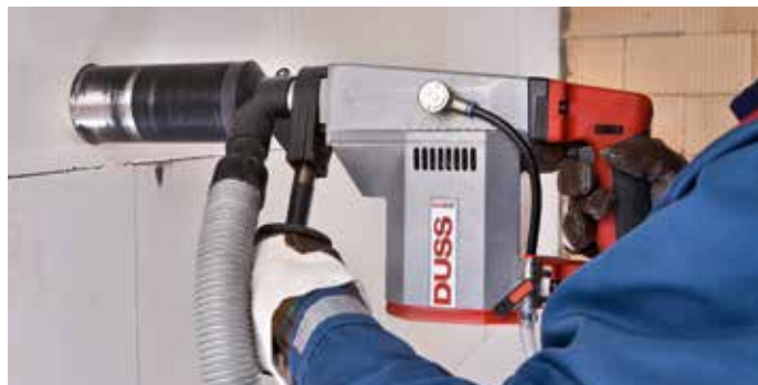
Dosensenken trocken in Kalksandstein mit Staubabsaugung
