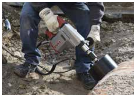
Anbohren von Kunststoffrohr – trocken, handgeführt
